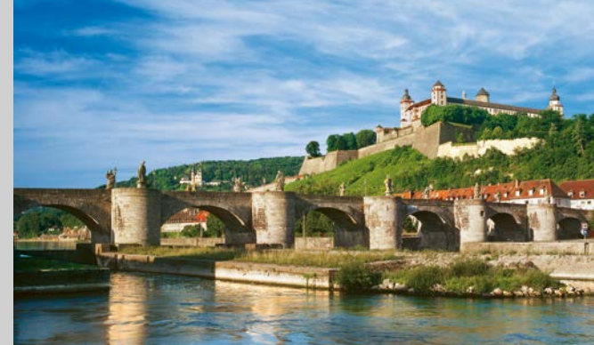
Festung Marienberg und Alte Mainbrücke von Nordosten
