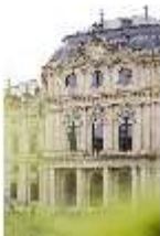
WüRes.I, Kaisersaalpavillon, Ostfassade, DI028688, BSV-
