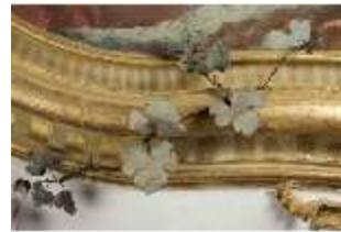
WüRes.II, Kaisersaal, Rahmendetail aus Gipsstuck, DI012324, BSV-
