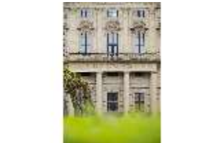
WüRes.V, Ostfassade, Ostgarten, DI028706, BSV-
