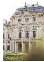
WüRes.I, Kaisersaalpavillon, Ostfassade, DI028687, BSV-
