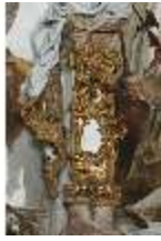
WüRes.II, Kaisersaal, R. 5, Plastische Wandvorlage, DI013493, BSV-
