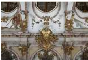
WüRes.II, Kaisersaal, R. 5, Westwand, DI013485, BSV-
