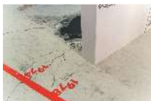
WüRes.II, Dokumentationsraum zum Wiederaufbau, DI019256, RSV.
