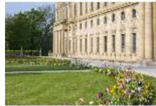
WüRes.V, Blumenrabatten vor Ostfassade, DI008959, BSV
