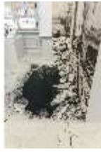
WüRes.II, Dokumentationsraum zum Wiederaufbau, DI019260, RSV.
