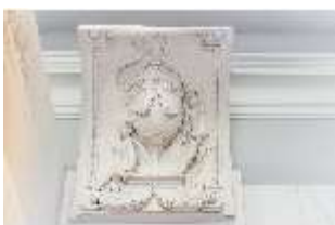
WüRes.II, Dokumentationsraum zum Wiederaufbau, DI019253, RSV.
