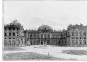
WüRes.I, Außenansicht 1947, DE002707, BSV-
