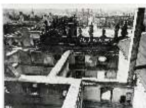
WüRes.I, Ohne Dach 1945, Kriegszerstörung, DE000234, BSV-
