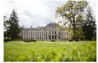
WüRes.I, Ostfassade mit Kaisersaalpavillon, DI028686, BSV-
