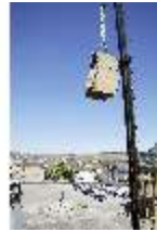
WüRes.I,P, Montage Balustradenfigur m.Blick a.Residenzpl., DI021022, BSV-
