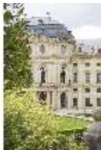
WüRes.I, Kaisersaalpavillon, Ostfassade, DI028691, BSV-
