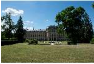
WüRes.I, Ostfassade mit Kaisersaal, DI007310, BSV
