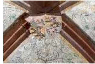
WüFg.II, Vorzimmer (R.9), Erker, Schlussstein, DI000820, BSV-
