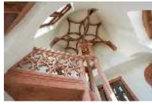
WüFg.II, Bibratreppe, Schlingruppengewölbe (R.16), DI000816, BSV-
