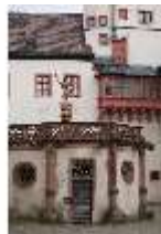
WüFg.I, Brunnenbau, DI016021, BSV-
