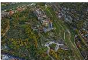
WüFg.I, Luftaufnahme, Blick von Nordwesten, DI000840, BSV-
