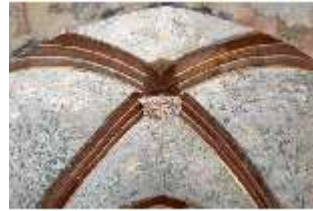
WüFg.II, Vorzimmer (R.9), Erker, Gewölbe mit Schlussstein, DI000819, BSV-
