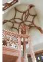
WüFg.II, Bibratreppe, Schlingruppengewölbe (R.16), DI000817, BSV-
