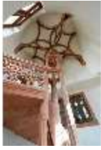
WüFg.II, Bibratreppe, Schlingruppengewölbe (R.16), DI000815, BSV-
