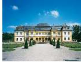
Vh.I, Westfassade und Schlossparterre, DE002039, BSV-
