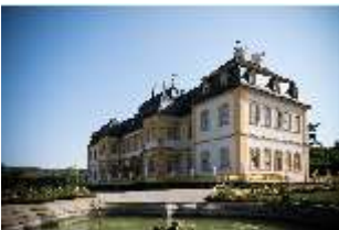
Vh.I, Südfassade, Westfassade, Schloss, DI027544, BSV-
