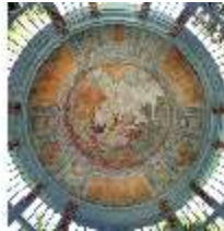
Vh.V, Südlicher Treillagepavillon, Deckenbild, DI025138, BSV
