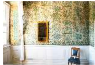
Vh.II, Schreibkabinett, Südwand, Toskana-Appartement, R. 11, DI027726, BSV-
