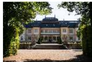
Vh.V, Auffahrtsallee und Westfassade, Hofgarten, DI027603, BSV-
