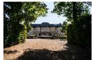
Vh.V, Auffahrtsallee und Westfassade, Hofgarten, DI027594, BSV-
