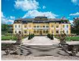
Vh.I, Hauptfassade, Westtreppe zum Parterre, DE002494, BSV
