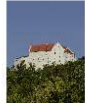
RieRo.I, Ostfassade, DI014825, BSV-
