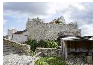
RieRo.I, Südfassade, DI014838, BSV-
