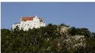
RieRo.I, Ostfassade, DI014830, BSV-
