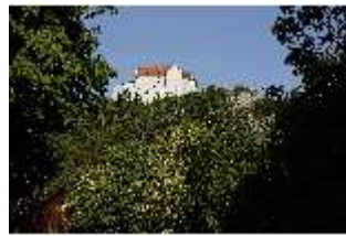
RieRo.I, Ostfassade, DI014827, BSV-
