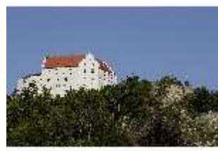
RieRo.I, Ostfassade, DI014828, BSV-
