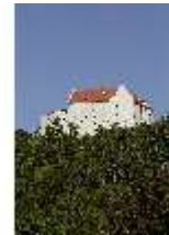
RieRo.I, Ostfassade, DI014829, BSV-
