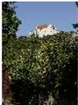
RieRo.I, Ostfassade, DI014826, BSV-
