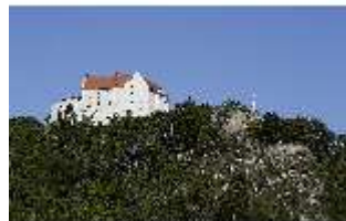
RieRo.I, Ostfassade, DI014831, BSV-
