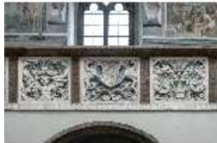
ND.II, Schosskapelle, Emporenbrüstung, DI002935, BSV
