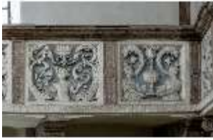
ND.II, Schosskapelle, Emporenbrüstung, DI002930, BSV
