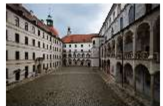
ND.I, Innenhof, Südansicht, DI027360, BSV
