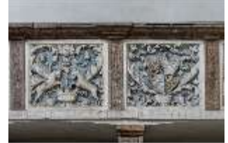
ND.II, Schosskapelle, Emporenbrüstung, DI002933, BSV
