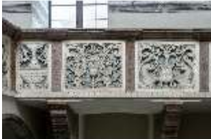
ND.II, Schosskapelle, Emporenbrüstung, DI002934, BSV
