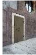
ND.I, Schosskapelle, zugemauertes Türchen, DI003518, BSV
