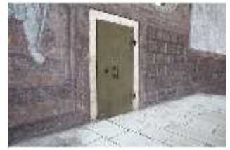
ND.I, Schosskapelle, zugemauertes Türchen, DI003519, BSV
