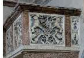
ND.II, Schosskapelle, Emporenbrüstung, DI002932, BSV
