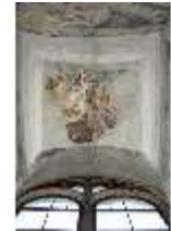
ND.II, Schosskapelle, Fensterzone, alttestament. Szene, DI002909, BSV
