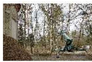
NyMa.I, Baumarbeiten, Magdalenenklausen, DI018786, BSV-
