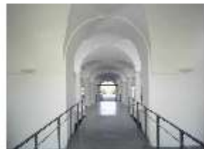
Ny.II, Eingang West, nicht eingerichtet, DI001485, BSV
