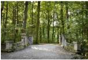
Ny.V, Brücke (beim Dörfchen, Kammerschleuse), DI001612, BSV
