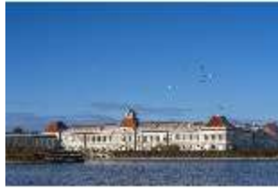
Ny.I, Orangerietrakt und Johannisbrunnhaus-Turm, DI029250, BSV-
