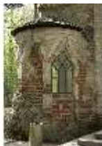
NyMa.I, Ansicht des südöstlichen Runderkers, DI029996, BSV
