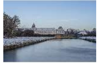
Ny.I, Orangerietrakt und Johannisbrunnhaus, DI029260, BSV-
