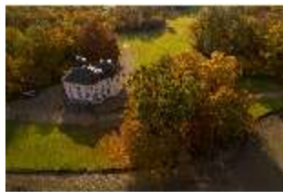
Ny.I, Luftaufnahme der Badenburg, DI028896, BSV-
