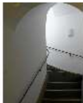
Ny.II, Treppe, Süd, DI001493, BSV
