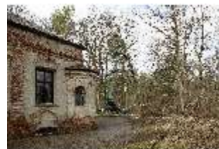
NyMa.I, Baumarbeiten, Magdalenenklausen, DI018782, BSV-
