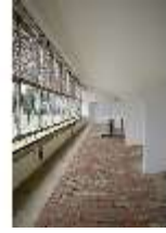
NyGe.II, Geranienhaus, Raumansicht, DI015938, BSV
