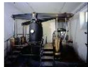
NyBru.II, Grünes Brunnhaus, östl. Pumpwerk, DE000656, BSV
