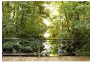
Ny.V, Brücke (Südeingang, erste Brücke), DI001614, BSV
