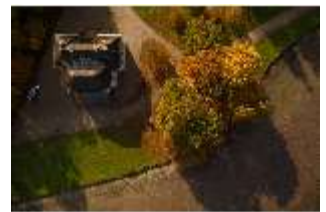
Ny.I, Luftaufnahme der Badenburg, DI028898, BSV-
