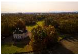
Ny.I, Luftaufnahme der Badenburg, DI028895, BSV-
