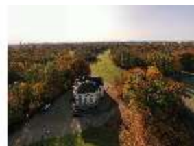
Ny.I, Luftaufnahme der Badenburg, DI028901, BSV-
