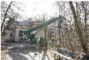
NyMa.I, Baumarbeiten, Magdalenenklausen, DI018776, BSV-
