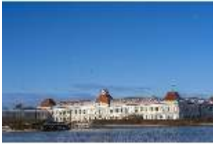
Ny.I, Orangerietrakt und Johannisbrunnhaus-Turm, DI029248, BSV-
