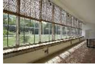
NyGe.II, Geranienhaus, Raumansicht, DI015937, BSV
