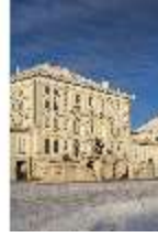
Ny.I, Mittelbau des Hauptschlusses, Stadtseite, DI029222, BSV-
