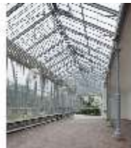
NyEi.II, Eisernes Haus, DI001513, BSV
