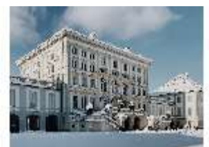
Ny.I, Stadtfassade, Mittelbau im Schnee, DI029046, BSV-
