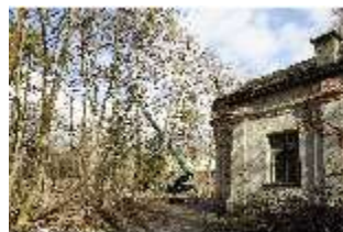
NyMa.I, Baumarbeiten, Magdalenenklausen, DI018781, BSV-
