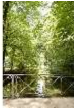
Ny.V, Brücke (Südeingang, erste Brücke), DI001613, BSV
