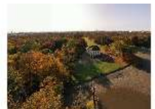
Ny.I, Luftaufnahme der Badenburg, DI028902, BSV-
