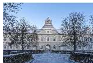
Ny.I, Hauptverwaltung, verschneiter Innenhof, DI029214, BSV-
