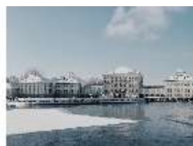
Ny.I, Stadtfassade, Bassin im Schnee, DI029049, BSV-
