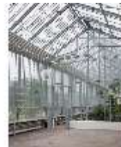
NyEi.II, Eisernes Haus, DI001514, BSV
