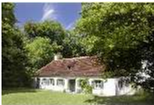
Ny.V, Dörfchen, Brunnwärterhaus, DI001615, BSV
