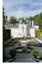
Lin. I, Ostfassade und östliches Parterre, DI005861, BSV
