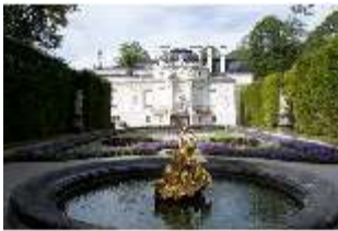
Lin. I, Ostfassade und östliches Parterre, DI005863, BSV
