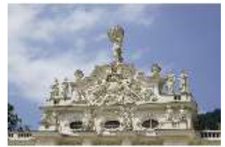
Lin.I, Giebel der Hauptfassade/Südfassade, DI023223, BSV
