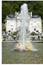
Lin.I, Hauptfassade, großes Bassin, DI005797, BSV
