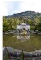
Lin.I, Hauptfassade, großes Bassin, DI005781, BSV
