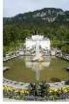
Lin.I, Hauptfassade, großes Bassin, DI005793, BSV
