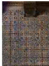
Lin.II, Maurischer Kiosk, Bodenfliesen, DI008924, BSV-
