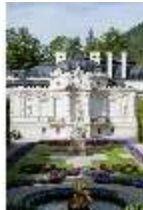
Lin. I, Ostfassade und östliches Parterre, DI005857, BSV
