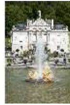
Lin.I, Hauptfassade, großes Bassin, DI005799, BSV
