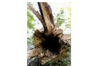
Lin.V, Wald, Baumarbeiten, DI016791, BSV-
