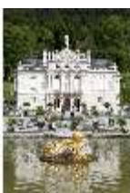
Lin.I, Hauptfassade, großes Bassin, DI005788, BSV
