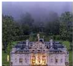
Lin.VII, Südfassade, Abend, DI033352, BSV-
