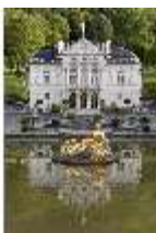
Lin.I, Hauptfassade, großes Bassin, DI005784, BSV
