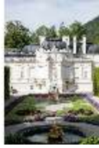
Lin. I, Ostfassade und östliches Parterre, DI005860, BSV
