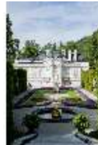
Lin. I, Ostfassade und östliches Parterre, DI005858, BSV
