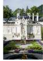
Lin. I, Ostfassade und östliches Parterre, DI005862, BSV
