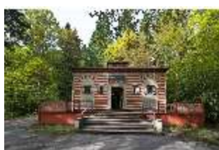
Lin.I, Marokkanisches Haus, Süd-West Fassade, DI008925, BSV-
