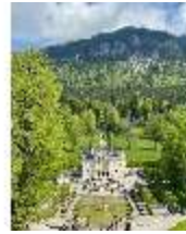
Lin.V, Nordhang, restaurierte Kaskade (2023), DI026553, BSV
