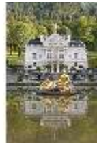
Lin.I, Hauptfassade, großes Bassin, DI005782, BSV
