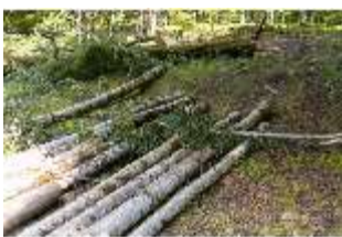
Lin.V, Wald, Baumarbeiten, DI016790, BSV-
