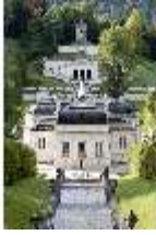
Lin.I,Nordfassade, Kasakade d. Nordhanges bis Terrassengärten, DI005879, RSV
