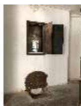
Lin.II, Technik, Heizung, DI015993, BSV-
