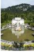
Lin.I, Hauptfassade, großes Bassin, DI005792, BSV
