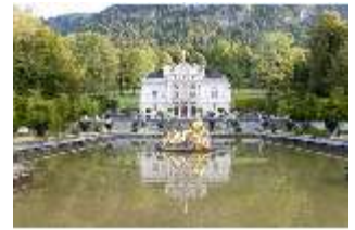
Lin.I, Hauptfassade, großes Bassin, DI005779, BSV
