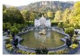
Lin.I, Hauptfassade, großes Bassin, DI005778, BSV
