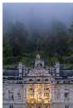
Lin.VII, Südfassade, Abend, DI033353, BSV-
