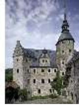
LauBg.I, Innenhof, Blick von SW, DI000289, BSV
