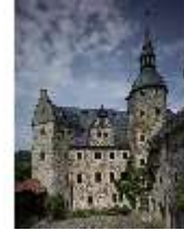
LauBg.I, Innenhof, Blick von SW, DI000290, BSV
