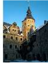
LauBg.I, Blick in den inneren Hof von SW im Winter, DI013367, BSV
