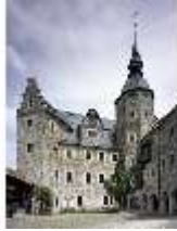
LauBg.I, Innenhof, Blick von SW, DI000288, BSV
