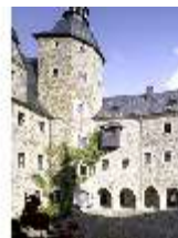
LauBg.I, Innenhof, Treppenturm und Orlamündebau, DI005497, BSV
