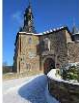
LauBg.I, Blick auf die Vorbürg mit Tor zum Innenhof im Winter, DI013368, BSV
