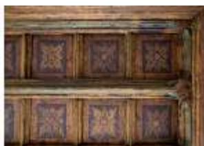
LauBg.II, Holzdecke, Detail (R.13), DI000323, BSV
