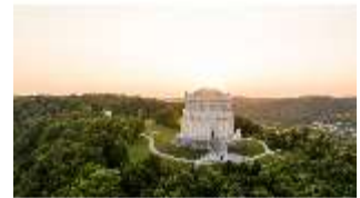
KeBf.I, Luftaufnahme, DI034063, BSV-
