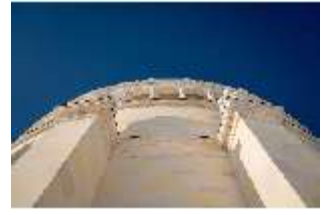
KeBf.I, Blick die Außenfassade hoch, DI013607, BSV-
