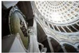
KeBf.II, Blick zur Kuppel, DI034101, BSV-
