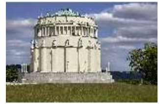
KeBf.I, Außenansicht Süd-Westen, DI014278, BSV-
