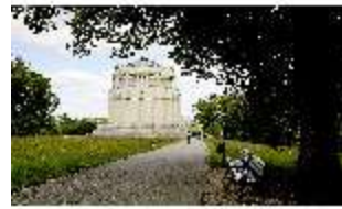
KeBf.I, Außenansicht Süd-Westen, DI014273, BSV-
