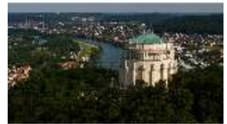
KeBf.I, Luftaufnahme, DI034035, BSV-
