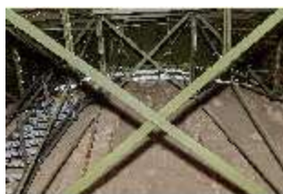
KeBf.II, Dachboden, DI014213, BSV-
