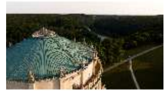
KeBf.I, Luftaufnahme, DI034055, BSV-
