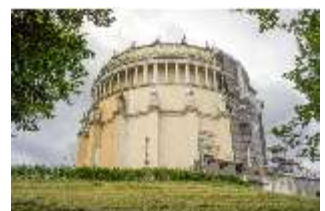
KeBf.I, Haupteingang, rekonstruierte Farbfassung, 2016, DI029079, BSV
