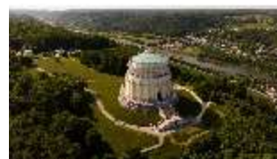
KeBf.I, Luftaufnahme, DI034038, BSV-
