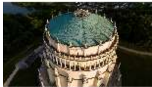
KeBf.I, Luftaufnahme, DI034057, BSV-
