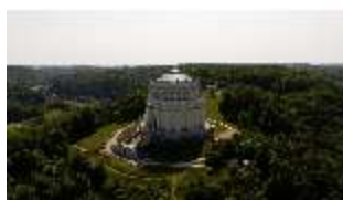
KeBf.I, Luftaufnahme, DI034025, BSV-
