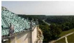
KeBf.I, Luftaufnahme, DI034033, BSV-
