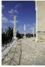
KeBf.I, Kandellabergang im Westen, DI014437, BSV-
