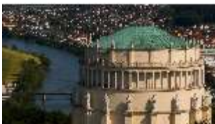
KeBf.I, Luftaufnahme, DI034036, BSV-
