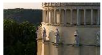
KeBf.I, Luftaufnahme, DI034043, BSV-
