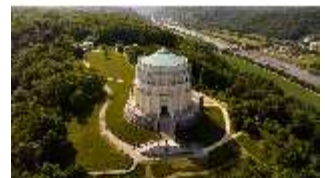
KeBf.I, Luftaufnahme, DI034039, BSV-
