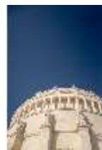
KeBf.I, Außenfassade, DI013606, BSV-
