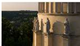
KeBf.I, Luftaufnahme, DI034045, BSV-
