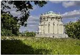
KeBf.I, Außenansicht Süd-Westen, DI014275, BSV-
