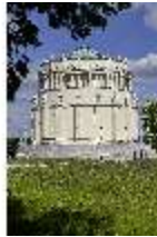
KeBf.I, Außenansicht Süd-Westen, DI014276, BSV-
