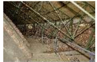
KeBf.II, Dachboden, DI014207, BSV-
