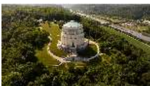
KeBf.I, Luftaufnahme, DI034040, BSV-
