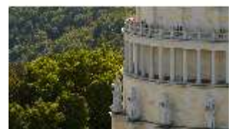
KeBf.I, Luftaufnahme, DI034027, BSV-
