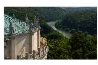
KeBf.I, Luftaufnahme, DI034023, BSV-
