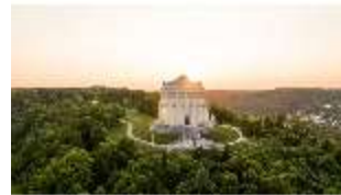
KeBf.I, Luftaufnahme, DI034062, BSV-
