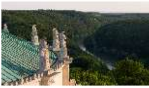
KeBf.I, Luftaufnahme, DI034052, BSV-
