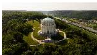
KeBf.I, Luftaufnahme, DI034041, BSV-
