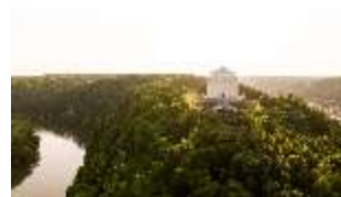
KeBf.I, Luftaufnahme, DI034050, BSV-
