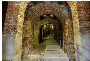
KeBf.II, Gewölbe, DI014221, BSV-
