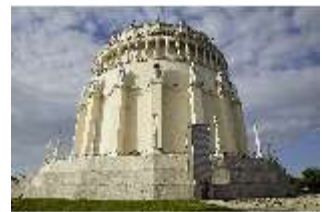
KeBf.I, Außenansicht Norden, DI014249, BSV-
