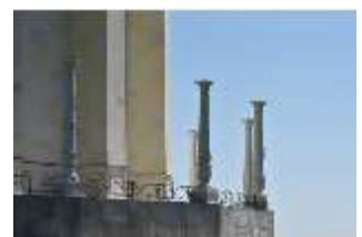
KeBf.I, Kandelaber auf der Sockelplattform, DI011077, BSV-
