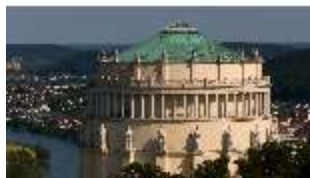
KeBf.I, Luftaufnahme, DI034037, BSV-
