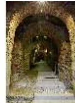
KeBf.II, Gewölbe, DI014223, BSV-
