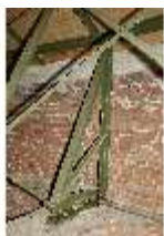
KeBf.II, Dachboden, DI014212, BSV-
