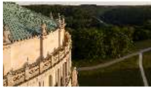
KeBf.I, Luftaufnahme, DI034053, BSV-
