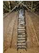
KeBf.II, Dachboden, DI014211, BSV-
