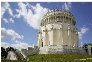
KeBf.I, Außenansicht Nord- Osten, DI014246, BSV-
