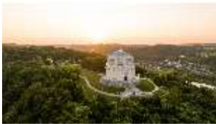
KeBf.I, Luftaufnahme, DI034060, BSV-
