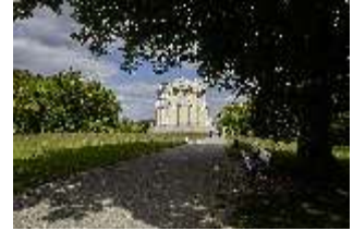
KeBf.I, Außenansicht Süd-Westen, DI014274, BSV-
