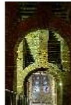
KeBf.II, Gewölbe, DI014226, BSV-
