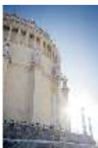
KeBf.I, Außenfassade, DI013659, BSV-
