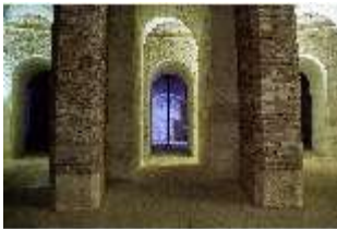
KeBf.II, Gewölbe, DI014435, BSV-
