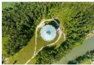
KeBf.I, Luftaufnahme, DI034021, BSV-
