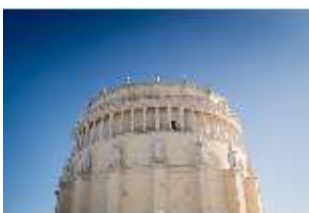
KeBf.I, Außenfassade, DI013648, BSV-
