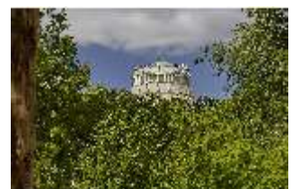
KeBf.I, Südfassade, DI014462, BSV-
