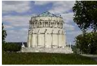
KeBf.I, Außenansicht Süd-Westen, DI014272, BSV-
