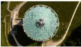
KeBf.I, Luftaufnahme, DI034028, BSV-
