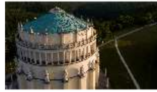
KeBf.I, Luftaufnahme, DI034054, BSV-
