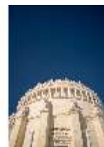
KeBf.I, Außenfassade, DI013613, BSV-
