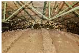
KeBf.II, Dachboden, DI014209, BSV-
