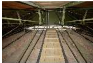
KeBf.II, Dachboden, DI029153, BSV
