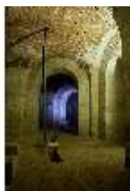
KeBf.II, Gewölbe, DI014228, BSV-
