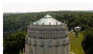
KeBf.I, Luftaufnahme, DI034026, BSV-
