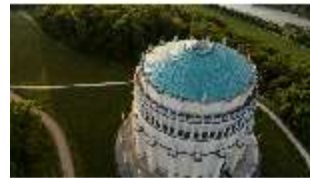
KeBf.I, Luftaufnahme, DI034058, BSV-
