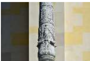
KeBf.I, Kandelaber auf der Sockelplattform, DI011079, BSV-
