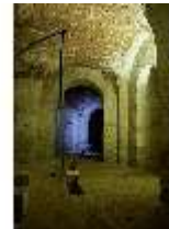
KeBf.II, Gewölbe, DI014227, BSV-
