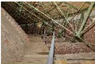
KeBf.II, Dachboden, DI014208, BSV-
