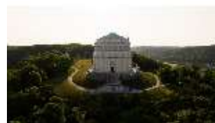
KeBf.I, Luftaufnahme, DI034042, BSV-
