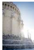
KeBf.I, Außenfassade, DI013660, BSV-
