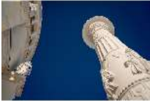
KeBf.I, Blick die Außenfassade hoch, DI013610, BSV-
