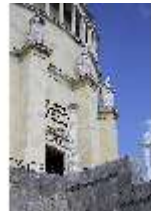
KeBf.I, Eingangsportal, DI014263, BSV-
