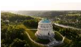
KeBf.I, Luftaufnahme, DI034048, BSV-
