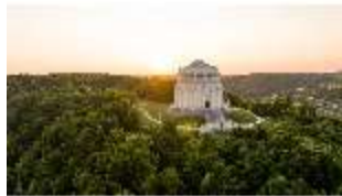
KeBf.I, Luftaufnahme, DI034061, BSV-
