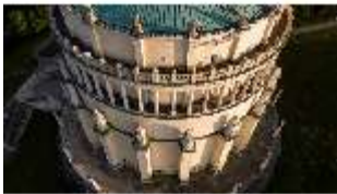
KeBf.I, Luftaufnahme, DI034056, BSV-
