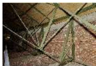
KeBf.II, Dachboden, DI014214, BSV-
