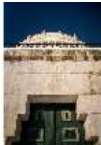
KeBf.I, Bronzeportal zum Treppenbau, DI013661, BSV-
