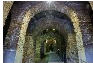
KeBf.II, Gewölbe, DI014222, BSV-
