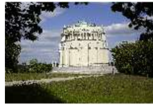
KeBf.I, Außenansicht Süd-Westen, DI014277, BSV-
