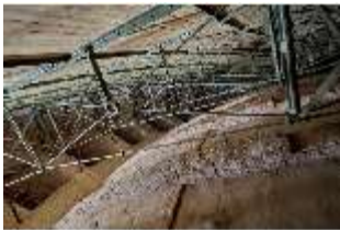
KeBf.II, Dachboden, DI029152, BSV
