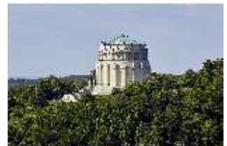
KeBf.I, Außenansicht Nord- Osten, DI014245, BSV-
