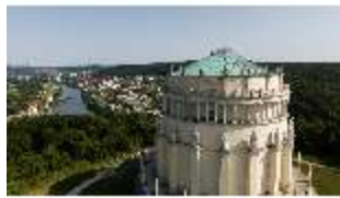
KeBf.I, Luftaufnahme, DI034029, BSV-
