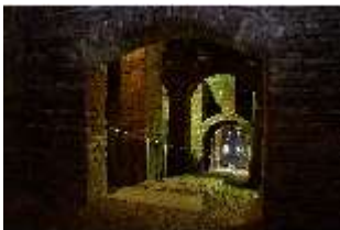
KeBf.II, Gewölbe, DI014224, BSV-
