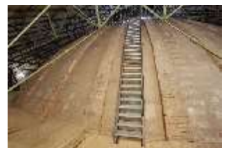
KeBf.II, Dachgeschoß, DI029151, BSV
