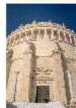
KeBf.I, Außenfassade, DI013662, BSV-
