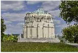
KeBf.I, Außenansicht Süd-Westen, DI014271, BSV-
