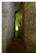
KeBf.II, Gewölbe, DI014229, BSV-
