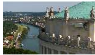
KeBf.I, Luftaufnahme, DI034030, BSV-
