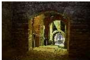
KeBf.II, Gewölbe, DI014225, BSV-
