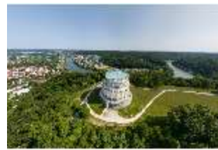
KeBf.I, Luftaufnahme, DI034022, BSV-
