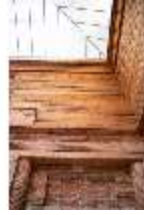
HchNS.II, Nördliches Treppenhaus, R. 20, DI020503, BSV-
