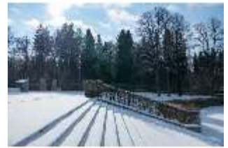
HchNS.V, Treppe, Westliche Gartenachse, DI018807, BSV
