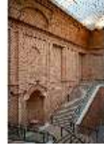
HchNS.II, Nördliches Treppenhaus, R. 20, DI020504, BSV-
