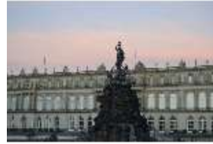
HchNS.I, Westfassade mit Fortuna-Brunnen, DI006004, BSV-
