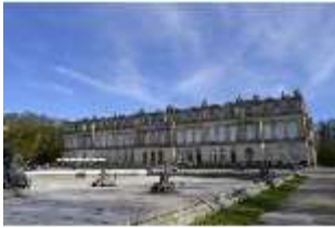
HchNS.I, Westfassade und südliches Bassin, DI005983, BSV-
