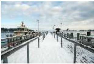
HchAS.V, Anlegestelle Schifffahrt, DI018787, BSV
