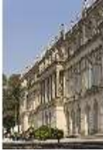
HchNS.I, Gartenfassade, DI003258, BSV-
