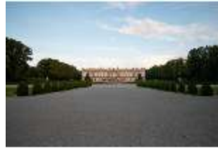
HchNS.I, Gartenfassade, Westfassade, DI020451, BSV-
