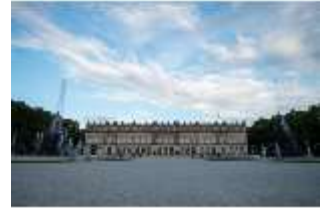
HchNS.I, Gartenfassade, Westfassade, DI020458, BSV-
