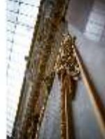
HchNS.II, Detail Wandgestaltung Prunktreppe, R. 3, DI020476, BSV-
