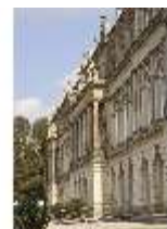
HchNS.I, Gartenfassade, DI003257, BSV-
