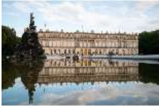
HchNS.I, Gartenfassade, Westfassade, DI020453, BSV-
