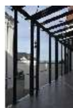
HchAS.II, Verbindungsgang, DI021698, BSV-
