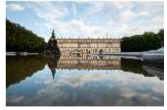
HchNS.I, Gartenfassade, Westfassade, DI020452, BSV-
