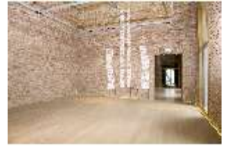
HchNS.II, Veranstaltungsräume (Rohbau), DI009729, BSV-
