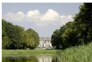
HchNS.V, Westfassade vom Kanal aus, DI006205, BSV
