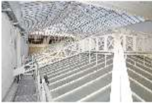
HchNS.II, Dachkonstruktion Treppenhaus, DI023682, BSV-
