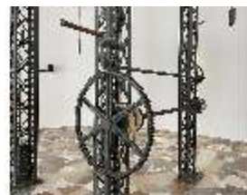
HchNS.II, Technikraum "Tischlein deck dich", DI019514, BSV-
