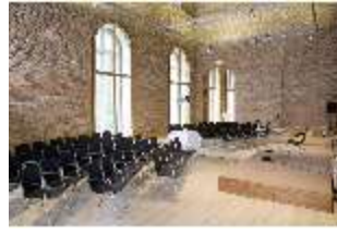
HchNS.II, Veranstaltungsräume (Rohbau), DI009728, BSV-
