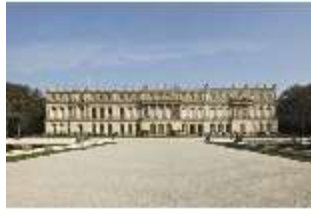
HchNS.I, Gartenfassade, DI003259, BSV-
