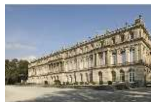
HchNS.I, Gartenfassade, DI003262, BSV-
