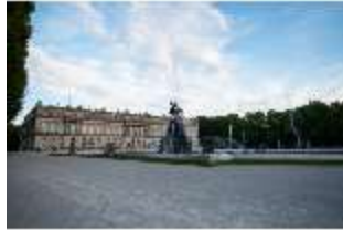
HchNS.I, Gartenfassade, Westfassade, DI020454, BSV-
