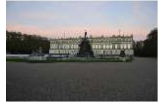
HchNS.I, Westfassade mit Fortuna-Brunnen, DI006005, BSV-
