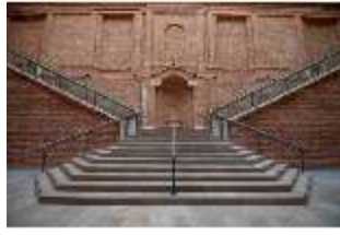
HchNS.II, Nördliches Treppenhaus, R. 20, DI020502, BSV-
