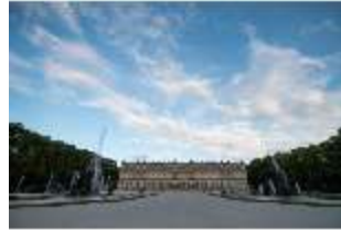
HchNS.I, Gartenfassade, Westfassade, DI020457, BSV-
