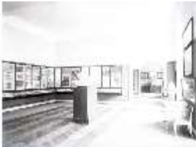
LIIMus.II, Raumaufnahme, Saal IV, Zustand 1926, DE004286, BSV-
