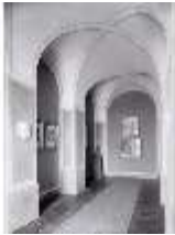
LIIMus.II, Raumaufnahme, Saal III, Zustand 1926, DE004283, BSV-
