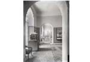
LIIMus.II, Raumaufnahme, Saal V, Zustand 1926, DE004289, BSV-
