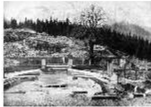
LII Mus. III: Foto Baustelle Linderhof, Lin., DE002499, BSV
