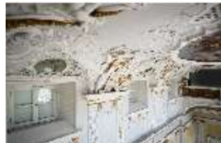
Ell.II, Festsaal, Deckengestaltung, R. 206, DI034391, BSV-
