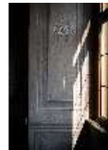
Ell.II, Speisesaal, Südwall, Fensternischen, Detail, R. 108, DI034466, BSV-
