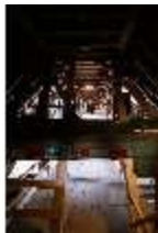
Ell.II, Dachstuhl, DI023160, BSV-
