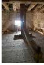
Ell.II, Dachstuhl, DI023063, BSV-
