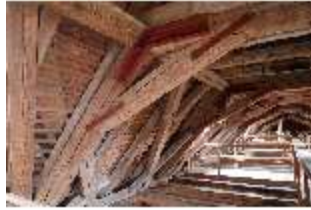
Ell.II, Dachstuhl, DI023044, BSV-
