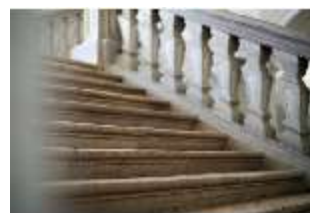
Ell.II, Treppenhaus, Stufen, Balustrade und Handlauf, DI034313, BSV-
