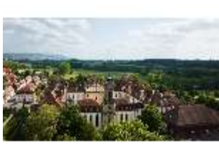
Ell.I, Gartenfassade, Schlosskirche, Luftaufnahme, DI034206, BSV-
