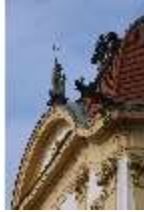
Ell.I, Giebel an der Südfassade, DI023030, BSV-
