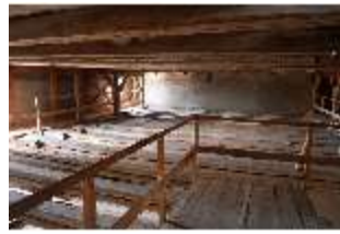
Ell.II, Dachstuhl, DI023092, BSV-
