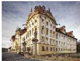
Ell.I, Fassade der Stadtseite, DI015472, BSV-
