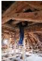
Ell.II, Dachstuhl, DI023156, BSV-
