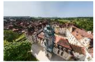
Ell.I, Turm der Schlosskirche, Luftaufnahme von Norden, DI034193, BSV-
