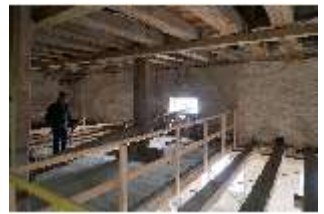
Ell.II, Dachstuhl, DI023053, BSV-
