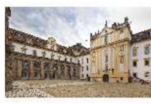
Ell.I, Innenhof, innere südliche Fassade, DI015469, BSV-
