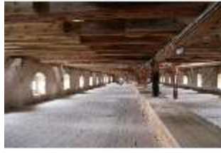
Ell.II, Dachstuhl, DI023040, BSV-
