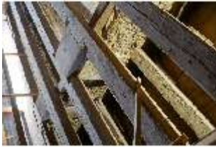
Ell.II, Dachstuhl, DI023069, BSV-
