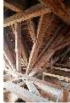
Ell.II, Dachstuhl, DI023045, BSV-
