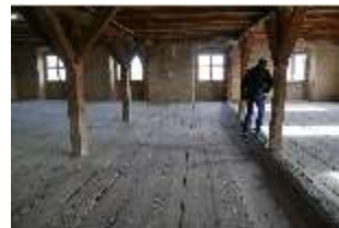
Ell.II, Dachstuhl, DI023157, BSV-
