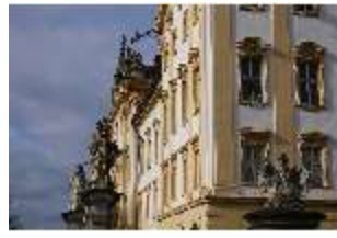
Ell.I, Südfassade und Ostflügel, DI023026, BSV-
