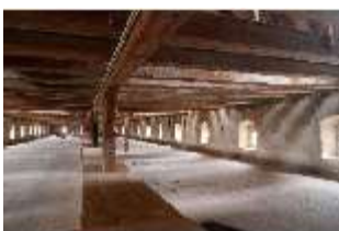
Ell.II, Dachstuhl, DI023035, BSV-
