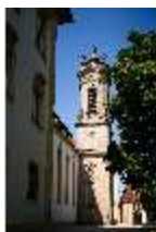
Ell.I, Gartenfassade, Schlosskirche mit Glockenturm, DI034295, BSV-
