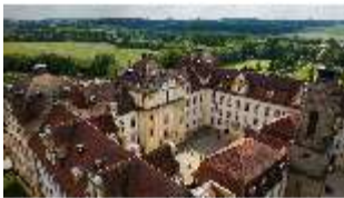
Ell.I, Innenhof, Luftaufnahme von Nord/Ost, DI034207, BSV-
