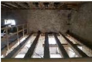
Ell.II, Dachstuhl, DI023054, BSV-
