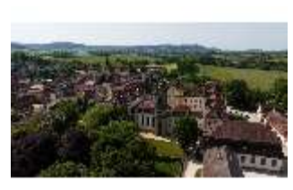
Ell.I, Residenz Ellingen, Luftaufnahme von Nord/West, DI034222, BSV-
