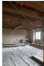
Ell.II, Dachstuhl, DI023052, BSV-
