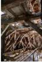
Ell.II, Dachstuhl, DI023062, BSV-
