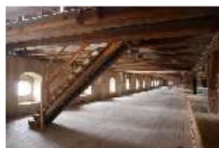
Ell.II, Dachstuhl, DI023036, BSV-
