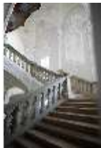
Ell.II, Treppenhaus, Blick nach oben, ins 2.OG, DI034303, BSV-
