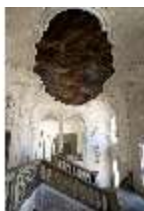
Ell.II, Deckengewölbe, Treppenhaus, 2. OG, DI034308, BSV-
