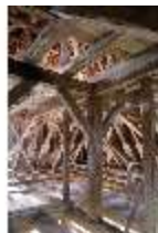
Ell.II, Dachstuhl, DI023060, BSV-
