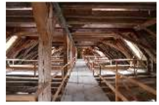
Ell.II, Dachstuhl, DI015914, BSV
