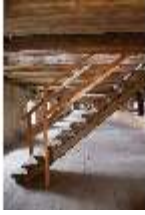
Ell.II, Dachstuhl, DI023039, BSV-
