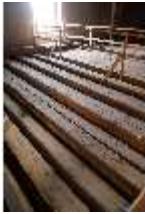
Ell.II, Dachstuhl, DI023090, BSV-
