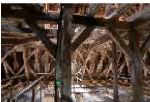
Ell.II, Dachstuhl, DI023058, BSV-
