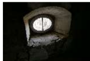
Ell.II, Dachstuhl, DI023165, BSV-
