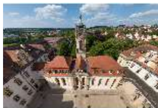
Ell.I, Schlosskirche, Hoffassade, Luftaufnahmen von Süden, DI034194, BSV-
