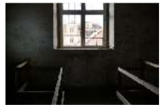
Ell.II, Dachstuhl, DI023162, BSV-
