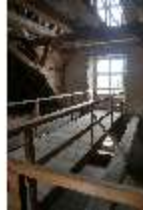
Ell.II, Dachstuhl, DI023041, BSV-
