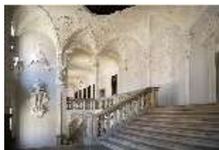
Ell.II, Treppenhaus, Korridor 2. OG, Minerva, DI034307, BSV-
