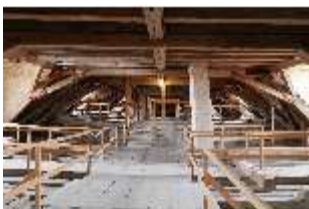
Ell.II, Dachstuhl, DI023163, BSV-
