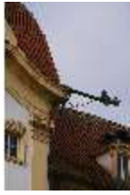
Ell.I, Südfassade mit Wasserspeier, DI023031, BSV-
