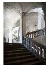
Ell.II, Treppenhaus, Blick nach oben, DI034299, BSV-
