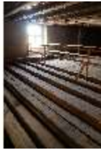
Ell.II, Dachstuhl, DI023091, BSV-
