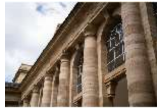
Ell.I, Innenhof, östl. Fassade und Kolonnade, DI034232, BSV-
