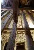
Ell.II, Dachstuhl, DI023070, BSV-
