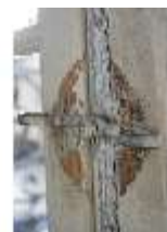
Ell.II, Fensterbeschlag (Detail), DI022811, BSV-
