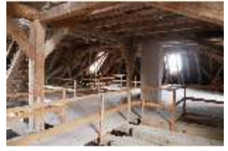
Ell.II, Dachstuhl, DI023042, BSV-
