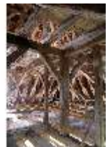
Ell.II, Dachstuhl, DI023061, BSV-
