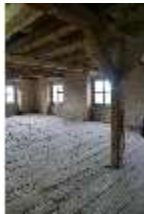
Ell.II, Dachstuhl, DI023051, BSV-
