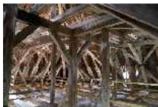
Ell.II, Dachstuhl, DI023059, BSV-
