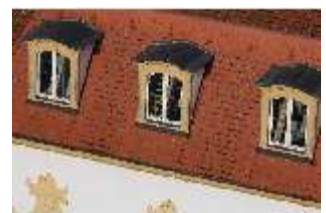
Ell.I, Blick vom Dach, Gaubenfenster, DI023143, BSV-
