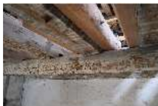
Ell.II, Dachstuhl, DI023164, BSV-
