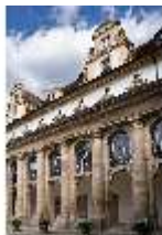
Ell.I, Innenhof, östl. Fassade und Kolonnade, DI034229, BSV-
