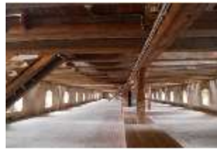
Ell.II, Dachstuhl, DI015913, BSV
