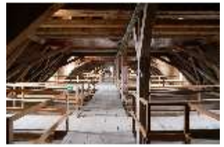
Ell.II, Dachstuhl, DI023049, BSV-
