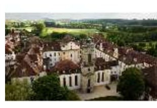
Ell.I, Gartenfassade, Schlosskirche, Luftaufnahme, DI034205, BSV-
