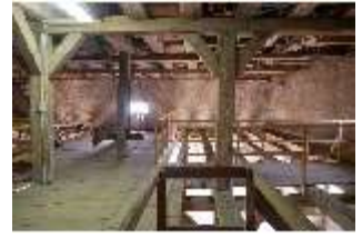
Ell.II, Dachstuhl, DI023065, BSV-
