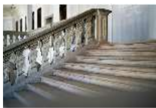
Ell.II, Stufen, Balustrade, Handlauf, Treppenhaus, 2. OG, DI034315, BSV-
