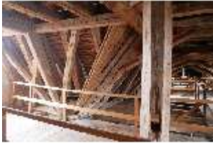
Ell.II, Dachstuhl, DI023043, BSV-
