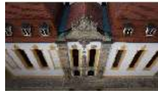
Ell.I, Schlosskirche, Fassade, Hofseite, Luftaufnahme, DI034202, BSV-
