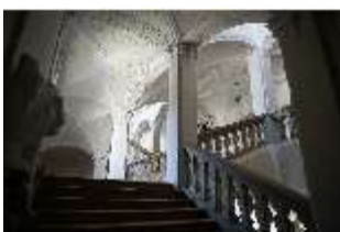
Ell.II, Treppenhaus, Blick nach oben, DI034300, BSV-
