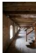
Ell.II, Dachstuhl, DI023037, BSV-
