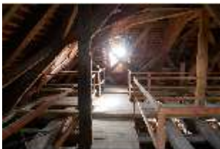
Ell.II, Dachstuhl, DI023155, BSV-
