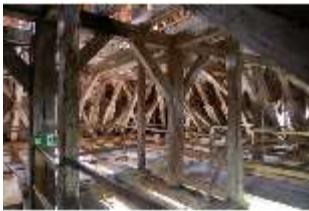
Ell.II, Dachstuhl, DI015915, BSV
