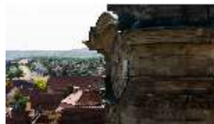
Ell.I, Turmuhr, Glockenturm, Luftaufnahme, DI034218, BSV-
