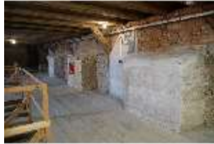
Ell.II, Dachstuhl, DI023075, BSV-
