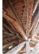
Ell.II, Dachstuhl, DI023046, BSV-
