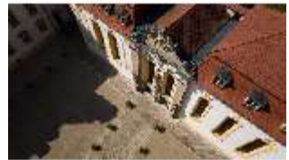
Ell.I, Schlosskirche, Fassade, Hofseite, Luftaufnahme, DI034203, BSV-
