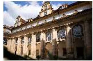
Ell.I, Innenhof, östl. Fassade und Kolonnade, DI034228, BSV-
