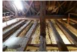
Ell.II, Dachstuhl, DI023071, BSV-
