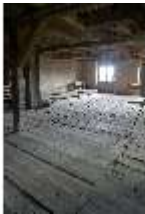
Ell.II, Dachstuhl, DI023050, BSV-
