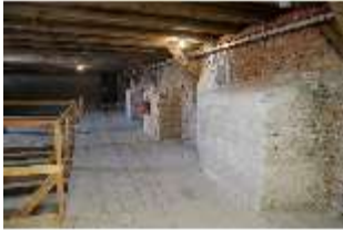
Ell.II, Dachstuhl, DI023074, BSV-
