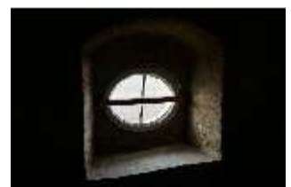
Ell.II, Dachstuhl, DI023038, BSV-
