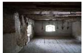
Ell.II, Dachstuhl, DI023166, BSV-
