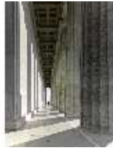
Wal.I, Westseite, Kolonnade, DI003153, BSV
