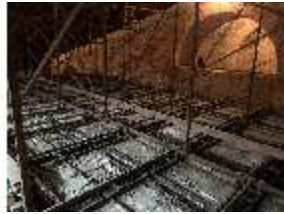
Wal.II, Dachstuhl, DI015832, BSV-
