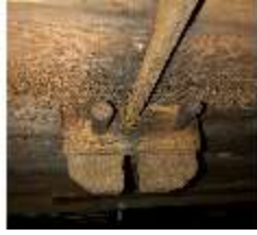
Wal.II, Dachstuhl, DI015824, BSV-
