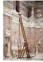
Wal.III,V, Historische Wartungsleiter, DI011710, BSV
