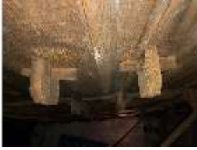
Wal.II, Dachstuhl, DI015823, BSV-
