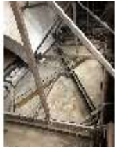
Wal.II, Dachstuhl, DI015827, BSV-
