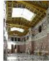
Wal.II, Blick durch den Innenraum, DI009317, BSV-
