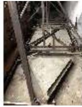
Wal.II, Dachstuhl, DI015828, BSV-
