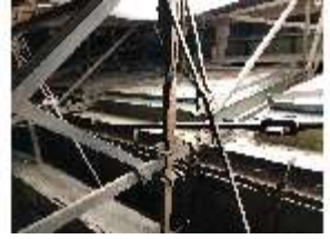
Wal.II, Dachstuhl, DI015826, BSV-
