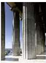
Wal.I, Kolonnade, Ausblick nach Südwesten, DI003159, BSV
