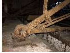
Wal.II, Dachstuhl, DI015825, BSV-
