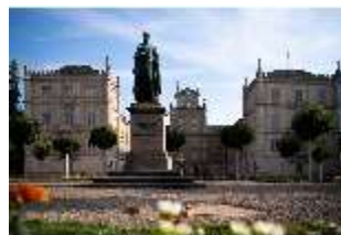
CoE.I, Schlossplatz mit Hauptfassade, DI024935, BSV-
