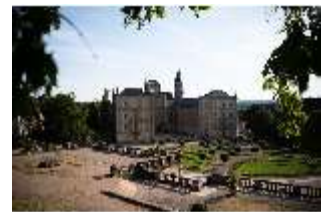
CoE.I, Hauptfassade mit Schlossplatz, DI024923, BSV-
