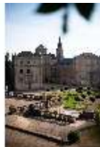
CoE.I, Hauptfassade mit Schlossplatz, DI024921, BSV-
