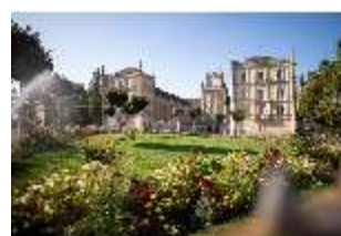
CoE.I, Hauptfassade mit Schlossplatz, DI025115, BSV-
