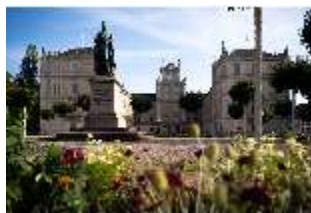
CoE.I, Schlossplatz mit Hauptfassade, DI024934, BSV-
