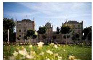
CoE.I, Schlossplatz mit Hauptfassade, DI024936, BSV-
