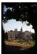
CoE.I, Hauptfassade mit Schlossplatz, DI024925, BSV-
