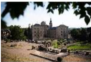
CoE.I, Hauptfassade mit Schlossplatz, DI024920, BSV-
