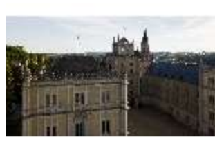
CoE.I, östlicher Flügel, Hauptfassade, DI024894, BSV-
