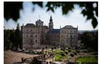
CoE.I, Hauptfassade mit Schlossplatz, DI024919, BSV-
