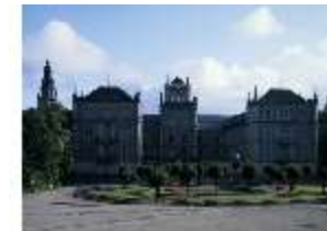
CoE.I, Schlossplatz und Hauptfassade, DE000141, BSV-
