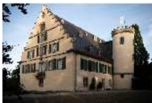
CoR.I, Nordfassade und Treppenturm, DI025443, BSV-
