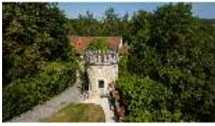
CoR.I, Luftaufnahme Rundturm, DI025247, BSV-
