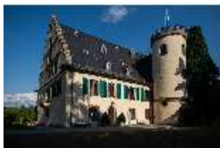
CoR.I, Nordfassade und Treppenturm, DI025451, BSV-
