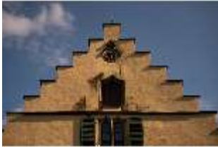
CoR.I, Giebel der Nordfassade, DI025457, BSV-
