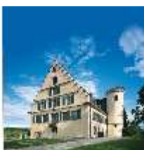
CoR.I, Ansicht von Nordwesten, DE000984, BSV
