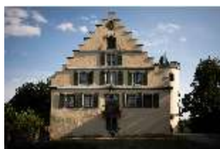
CoR.I, Nordfassade, DI025454, BSV-
