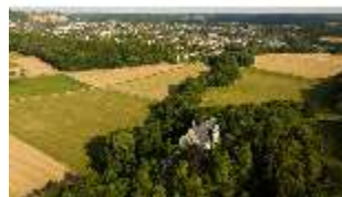
CoR.V, Luftaufnahme von NW, DI025261, BSV-
