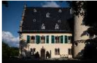
CoR.I, Westfassade mit Rundturm, DI025449, BSV-
