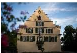
CoR.I, Nordfassade, DI025442, BSV-
