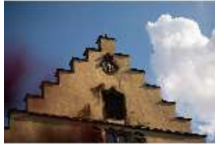
CoR.I, Giebel der Nordfassade, DI025458, BSV-
