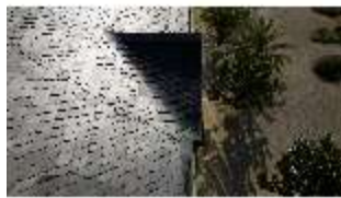
CoR.I, Luftaufnahme Orangerie Gaube, DI025235, BSV-
