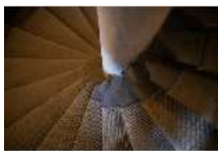
CoR.II, Wendeltreppe im Treppenturm, R. 4, DI025291, BSV-
