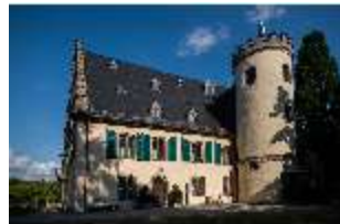
CoR.I, Westfassade mit Rundturm, DI025452, BSV-
