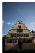
CoR.I, Nordfassade, DI025455, BSV-
