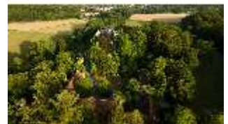
CoR.V, Luftaufnahme von NW, DI025265, BSV-
