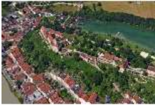
Bgh.I, Hauptburg, Luftaufnahme von Nordosten, DI003270, BSV
