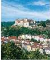
Bgh.I, Ansicht von Nordosten, DE001187, BSV-
