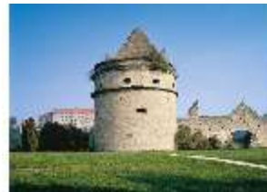
Bgh.I, Geschützturm (Pulverturm), DE002519, BSV-
