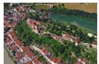
Bgh.I, Hauptburg, Luftaufnahme von Nordosten, DI003269, BSV
