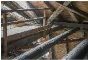
BayO.II, Balken im Dachstuhl, DI029088, BSV-
