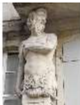
BayNS.I, Balkontrakt mit spätbarocken Hermen, DI022777, BSV
