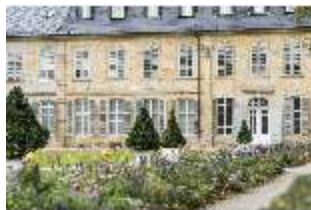
BayNS.V, Neues Schloss, Gartenfassade, DI028318, BSV-
