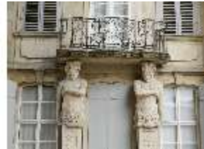
BayNS.I, Balkontrakt mit spätbarocken Hermen, DI022774, BSV
