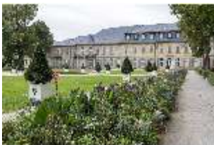
BayNS.V, Neues Schloss, Gartenfassade, DI028317, BSV-
