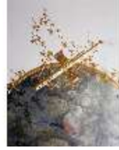
BayNS.II, Deckengem. u. - stuck, Det. R.1.14, DE001804, BSV-
