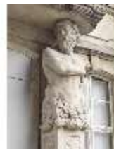
BayNS.I, Balkontrakt mit spätbarocken Hermen, DI022778, BSV
