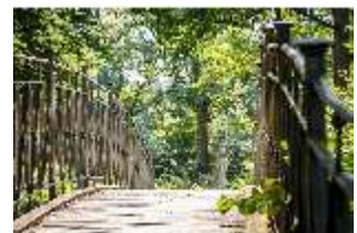
BayNS.V, Brücke über den Kanal, DI008436, BSV-
