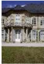
BayNS.I, Badetrakt, Fassade zur Gartenseite, DI022782, BSV
