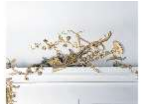
BayNS.II, Deckenstuckdet., Tri- angel, R.1.14, DE001814, BSV-
