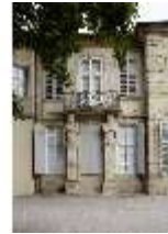
BayNS.I, Balkontrakt mit spätbarocken Hermen, DI022771, BSV
