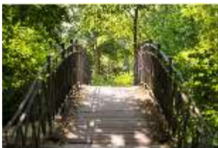
BayNS.V, Brücke zur Großen Insel, DI019879, BSV
