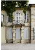
BayNS.I, Balkontrakt mit spätbarocken Hermen, DI022772, BSV
