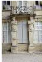
BayNS.I, Balkontrakt mit spätbarocken Hermen, DI022773, BSV
