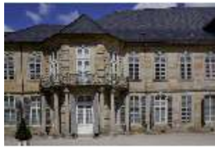
BayNS.I, Badetrakt, Fassade zur Gartenseite, DI022783, BSV
