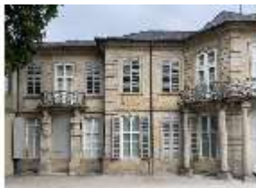
BayNS.I, Balkontrakt mit spätbarocken Hermen, DI022776, BSV
