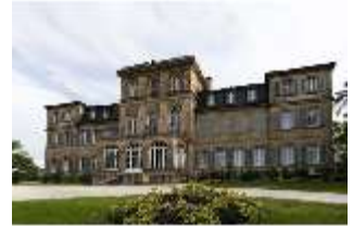
BayFa.I, Südfassade, DI017116, BSV-
