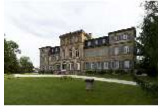
BayFa.I, Südfassade, DI017115, BSV-
