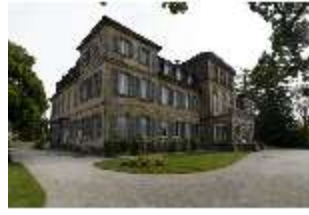
BayFa.I, Südfassade, DI017111, BSV-
