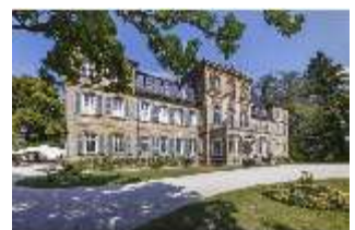
BayFa.I, Südfassade, DI002698, BSV
