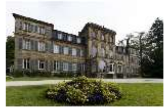
BayFa.I, Südfassade, DI017112, BSV-
