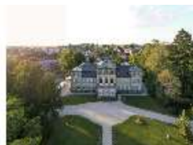
BayFa.I, Südfassade, DI017101, BSV-
