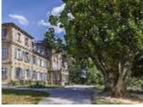
BayFa.I, Südfassade, DI002699, BSV
