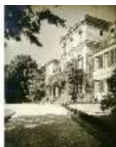
BayFa.I, Schrägsicht der Schlossfassade, DE004271, BSV
