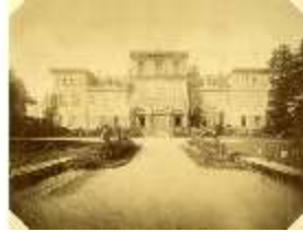
BayFa.I, Fassade, historische Aufnahme, DE001886, BSV
