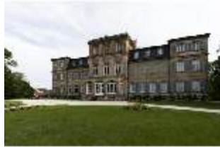
BayFa.I, Südfassade, DI017114, BSV-
