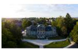
BayFa.I, Südfassade, DI017108, BSV-
