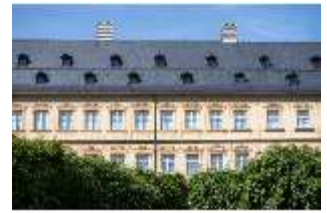
BaRes.I, Fassade des Gebtsattelbaus, DI020396, BSV
