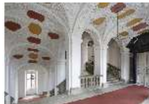
BaRes.II, Haupttreppenhaus im zweiten Obergeschoss, DI007218, BSV-
