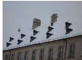
BaRes.I, Gartenseite, Verschneites Dach, DI022647, BSV
