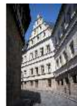
BaRes.I, Gebtsattelbau, Straßenflügel, DI020391, BSV
