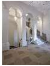
BaRes.II, Kabinetttreppe, Treppenanlage, R. 27, DI017553, BSV
