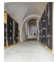
BaRes.II, Eingangsbereich, barrierefrei, DI017658, BSV
