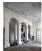
BaRes.II, 1. Obergeschoss, Treppe 4, DI009236, BSV-
