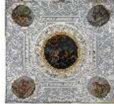
BaRes.II, Kaiserapp., Zweites Vorzimmer, Decke, DI009246, BSV-
