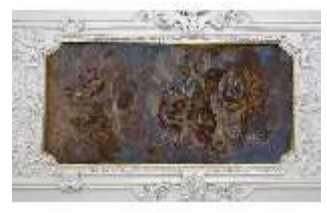
BaRes.II, Äußerer Vorsaal, Deckengemälde, DI009210, BSV
