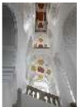
BaRes.II, Haupttreppenhaus im zweiten Obergeschoss, DI007217, BSV-
