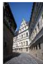
BaRes.I, Gebtsattelbau, Straßenflügel, DI020390, BSV
