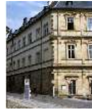
BaRes.I, Eingangstrakt Ecke Burggassentrakt, DE002600, BSV
