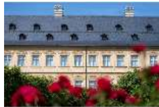
BaRes.I, Fassade des Gebtsattelbaus, DI020398, BSV
