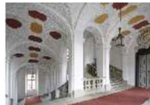
BaRes.II, Haupttreppenhaus im zweiten Obergeschoss, DI007219, BSV-
