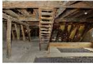
BaRes.II, Gebsattelbau, Dachstuhl, DI017651, BSV
