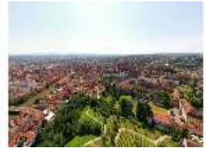
BaRes.I, Luftaufnahme von NW, DI025148, BSV
