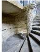
BaRes.II, Wendeltreppe, DI020689, BSV-
