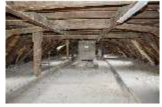
BaRes.II, Gebsattelbau, Dachstuhl, DI017652, BSV
