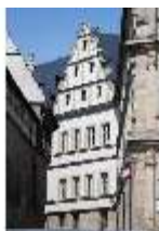
BaRes.I, Gebtsattelbau, Straßenflügel, DI020406, BSV
