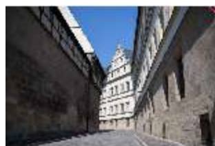
BaRes.I, Gebtsattelbau, Straßenflügel, DI020389, BSV
