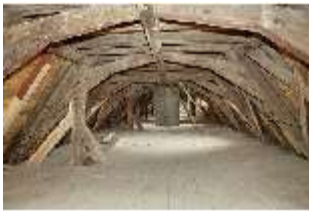
BaRes.II, Gebsattelbau, Dachstuhl, DI017653, BSV
