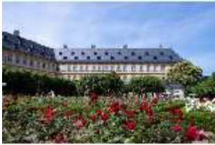
BaRes.V, Rosengarten, Hadergassenflügel (Gebtsattelbau), DI020418, BSV
