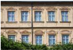
BaRes.I, Fassade des Gebtsattelbaus, DI020397, BSV
