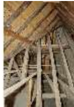
BaRes.II, Gebsattelbau, Dachstuhl, DI017654, BSV
