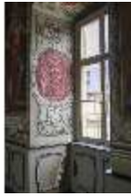
BaRes.II, Fensterlaibung, Kaisersaal, R. 9, DI020585, BSV
