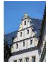
BaRes.I, Gebtsattelbau, Straßenflügel, DI020405, BSV
