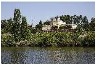
AschPomp.I, Südfassade vom Main aus, DI014981, BSV-
