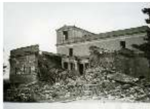
AschPomp.I, zerstörte Atriumstrakt, Ende 1944, DE003660, BSV-
