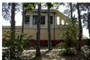
Aschpomp.V, Kiefernain mit Pompejanum, DI026892, BSV
