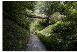
Aschpomp.V, Eisensteg bei ehem. Stadtgraben, DI026886, BSV
