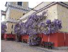
Aschpomp.I, Fassade von Süden, DI022670, BSV-
