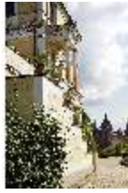
AschPomp.I, Freitreppe mit Agaven, DI014972, BSV-
