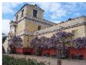
Aschpomp.I, Fassade von Süden, DI022671, BSV-
