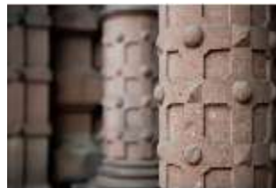
Asch.I, Det. Portal der Schlosskirche, DI024622, BSV-
