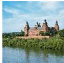
Asch.I, Blick von Süden, DE000358, BSV-
