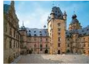
Asch.I, Innenhof mit Bergfried, DE001181, BSV-
