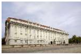
AnsRes.I, Hauptfassade, DI016450, BSV
