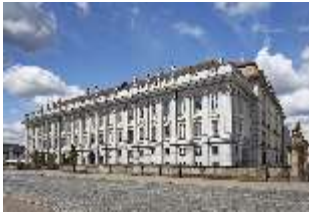
AnsRes.I, Hauptfassade, DI029772, BSV-
