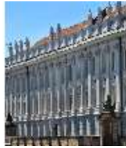
AnsRes.I, Residenz, Hauptfassade, Detailsicht, DI000686, BSV
