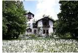
Ro.V, Südfassade des Casinos, DI010124, BSV-
