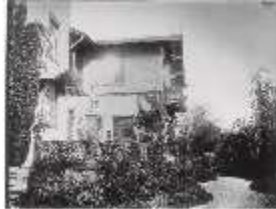
Ro.I, Südwestseite des Casinos (J.Albert), DE001688, BSV-
