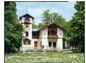
Ro.I, Casino, Südfassade, DE001247, BSV-
