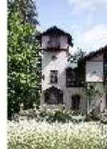
Ro.I, Turm an der S-Fassade Casino, DI010123, BSV-
